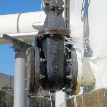
Oprava praskliny ventilu
