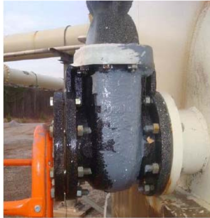
Oprava praskliny ventilu
